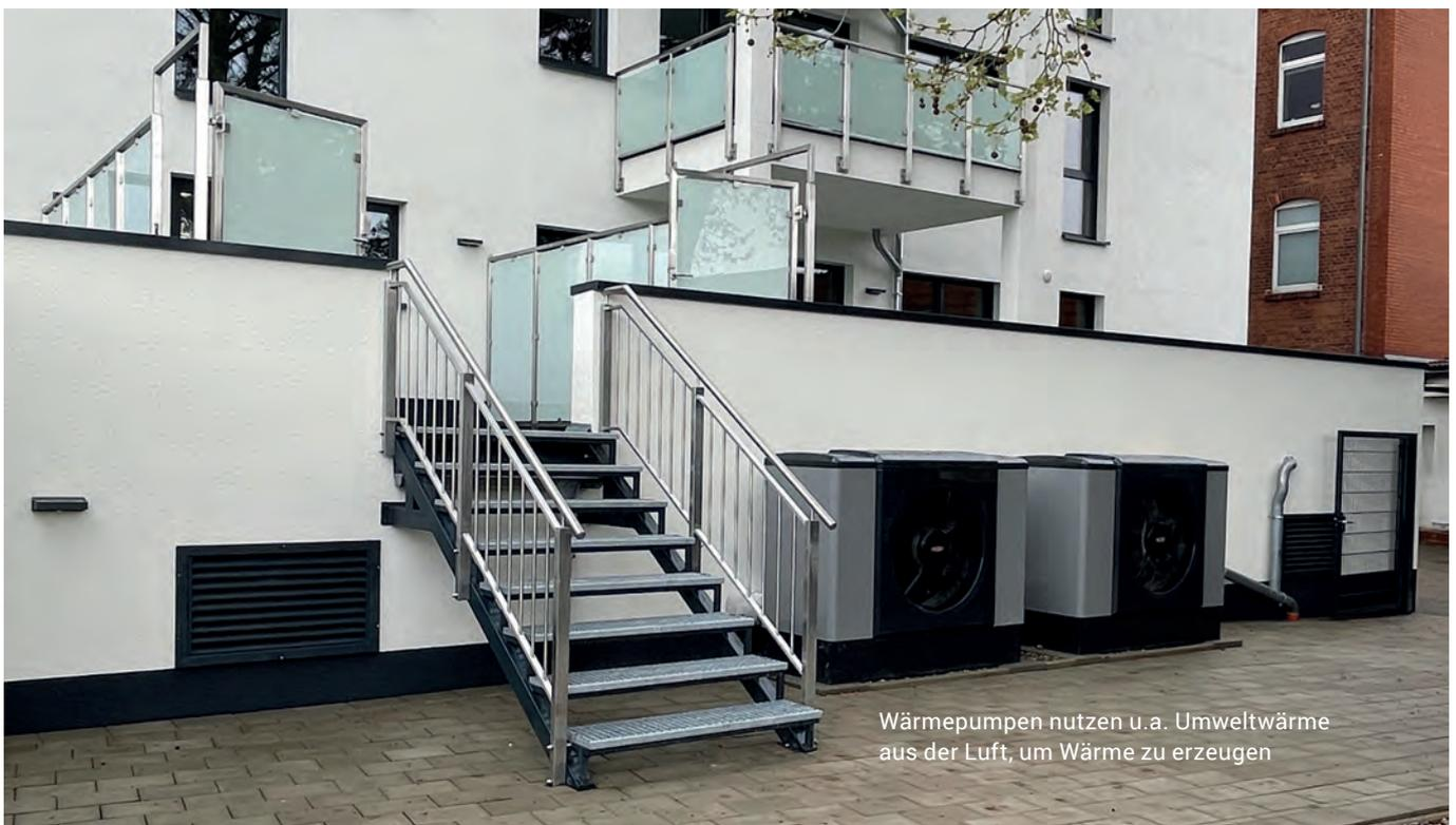
Wärmepumpen nutzen u.a. Umweltwärme aus der Luft, um Wärme zu erzeugen
